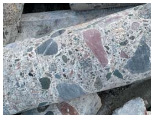
Рис. 1. Керны, отобранные из бетона конструкций плотины
