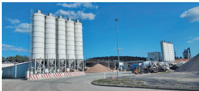
Рис. 1. Вид бетонного завода (БСУ)
