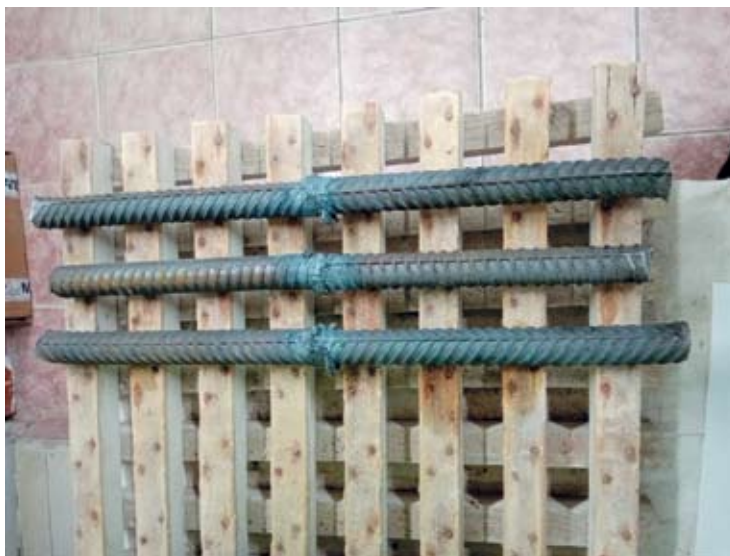
Рис. 3. Пример неправильного стыкования рабочих стержней арматуры
